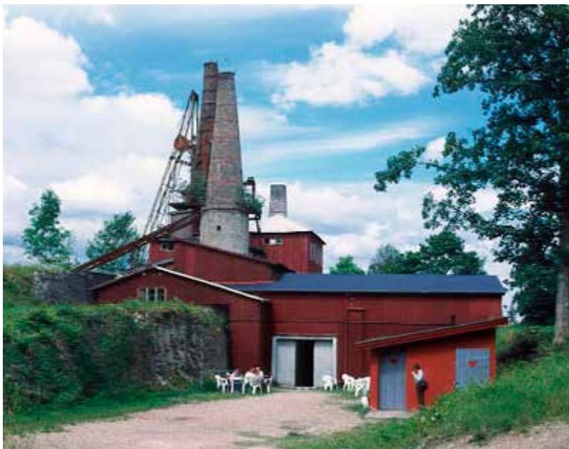
Kalkgruben's fabriksbygninger med ovne. Foto fra Mønsted Kalkgruber's hjemmeside
